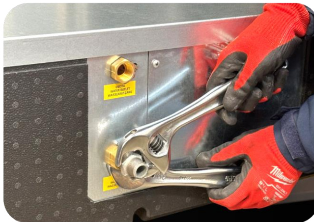
Posizione delle connessioni acqua e serraggio
